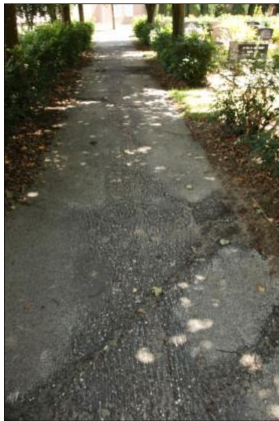
Bijgeschaafd asfaltpad om al te sterke vervorming tegen te gaan (gem. begraafplaats Coevorden)
